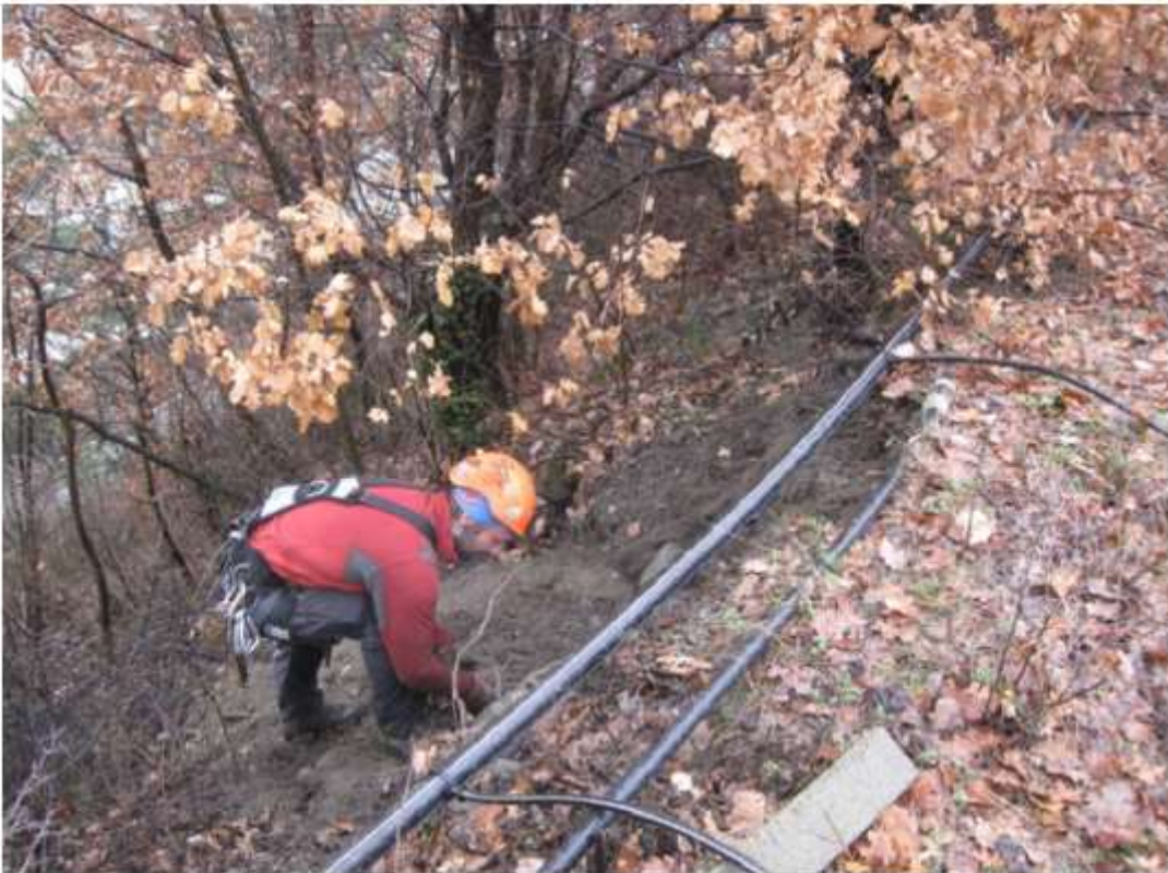
Operazione di pulizia della nicchia di distacco
